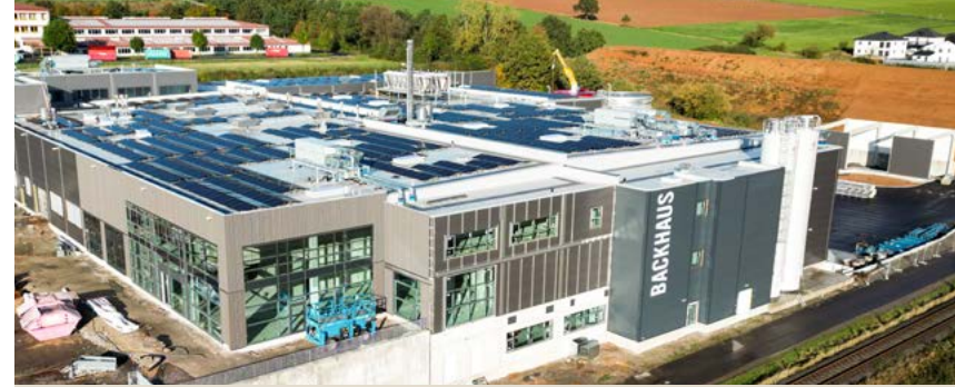
Projektsteuerung für den Neubau eines modernen und nachhaltigen Backhauses auf rund 35.000 m 2 papperts GmbH, Eichenzell
